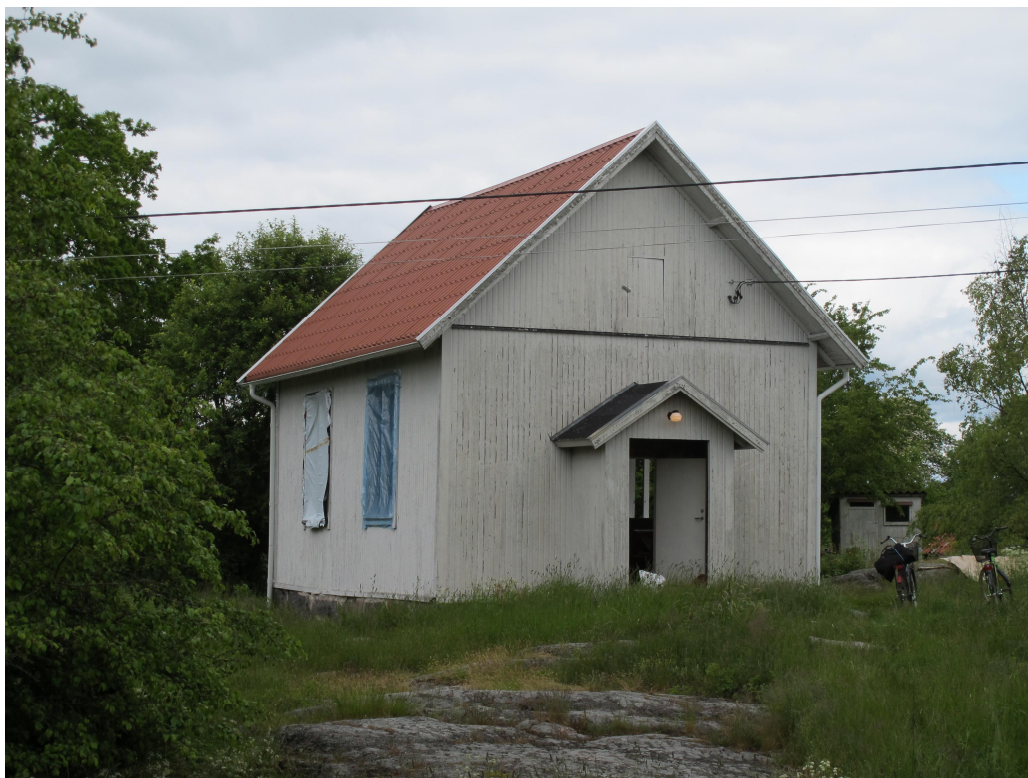
Bild. Kapellet under pågående fönsterrenovering. Här syns den påbyggda farstukvisiten. Byggnaden är numera inbäddad i grönska, vilket gör byggnaden mindre reslig. Gavelväggens horisontella panelskarv bidrar till ett mer kompakt fasadspråk. I fonden till höger skymtar utedasset.
