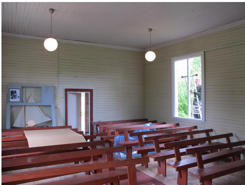
Bild. Kyrkorummet under pågående fönsterrenovering. Ovan fönstret löper list för upphängning av utställningsmaterial. En ny list kan med fördel göras mer smäcker och målas in i väggfärgen.
