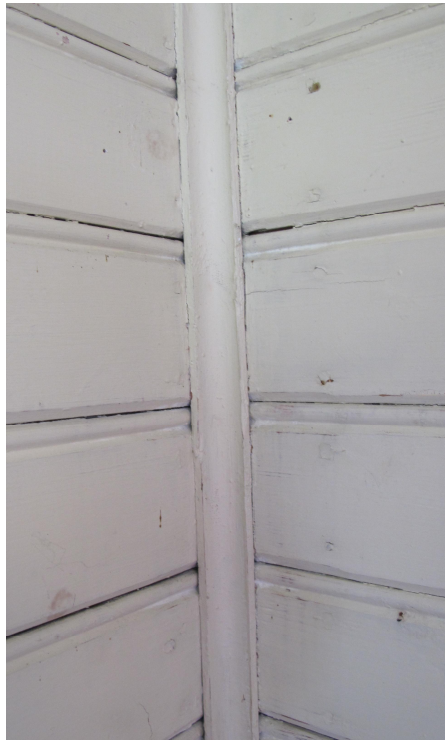
Bild. Tv. Armatur i vägghörn som troligtvis tillkom i samband med den anslutande gavelväggs skivinklädnad. Th. Rundad list i vägghörn.
