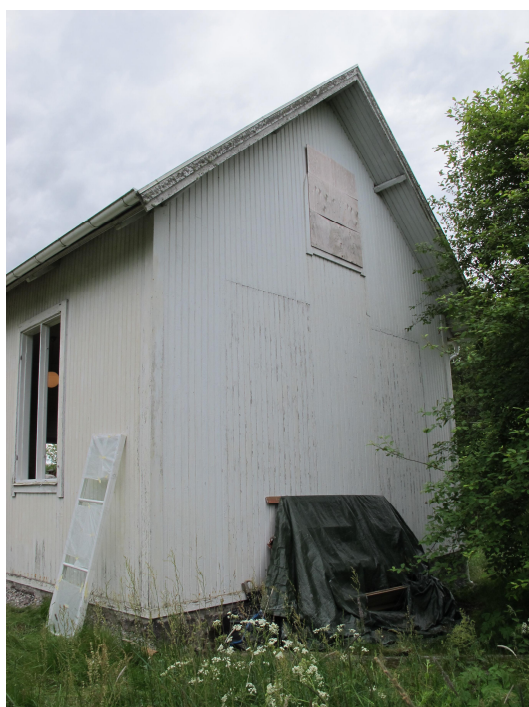
Bild. Gavelfasaden åt väster- under pågående fönsterreno- vering. Notera konturerna ef- ter bottenvåningens två igersatta fönster. Fuk- talstrande föremål står lutade mot fasaden.
