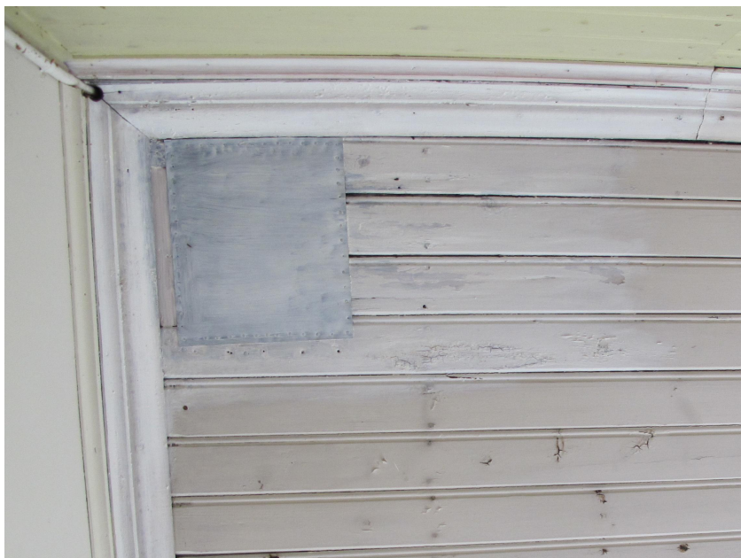
Bild. Taket med ilagning efter skorstensutgång. Den lagade takytan är målad lokalt.
