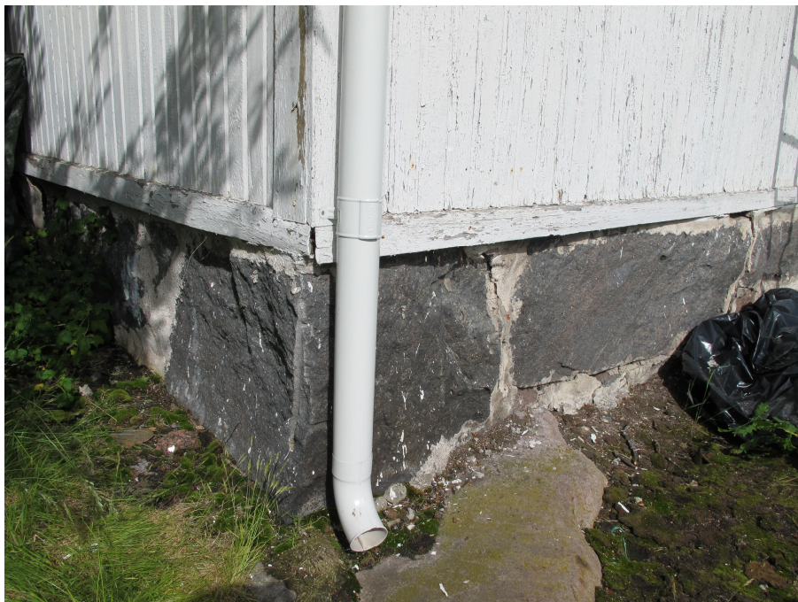
Bild: Söderfasadens stuprör ansluter till större sten/häll som lutar från fasaden. Risken för att utkastarens vatten ska tränga in i grunden är därmed minimal.
