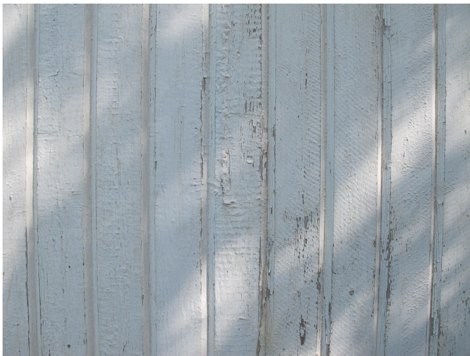
Bild: Gavelfasad åt väster. Fasadpanel med äldre ramsågade brädor till vänster och yngre klingsågade till höger. Färgen är krackelerad och flagar f läckvis. Särskilt på ytor med yngre panel.
