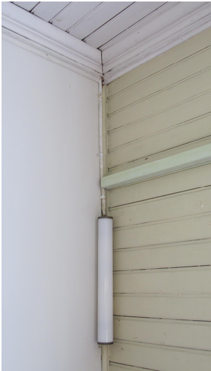
Bild. Tv. Armatur i vägghörn som troligtvis tillkom i samband med den anslutande gavelväggs skivinklädnad. Th. Rundad list i vägghörn.
